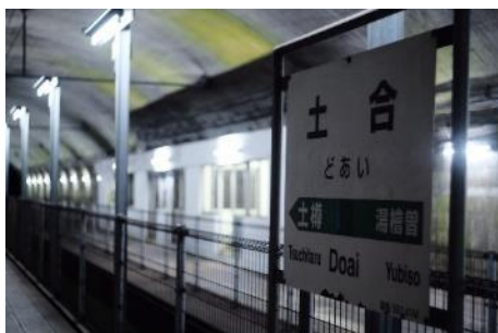
土合駅地下ホーム
